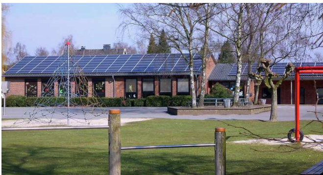
Die Photovoltaikanlage auf der Jakobi-Grundschule
